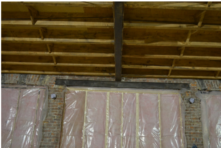
Structure de bois des planchers du corps central.
