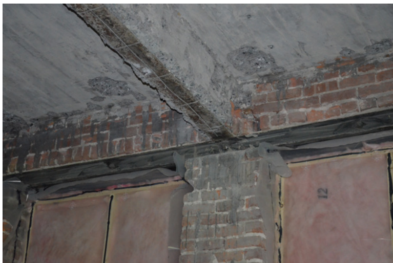
Poutre d'acier qui s'appuie sur un trumeau de maçonnerie entre deux fenêtres : linteau d'acier au dessus des fenêtres
