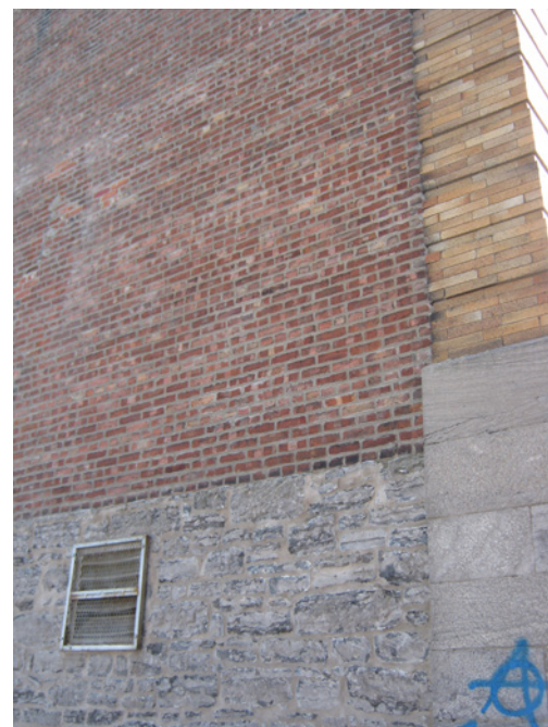
Raccord entre la maçonnerie de la façade sur rue et la maçonnerie de la façade arrière.
