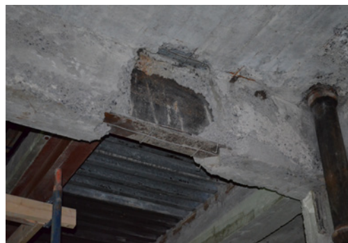
Poutres d'acier protégée par du béton (aile est). Une dalle de béton s'appuie sur les poutres d'acier.
