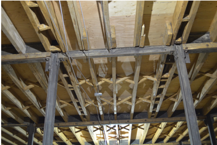
Structure de bois et d'acier du corps central du bâtiment.
