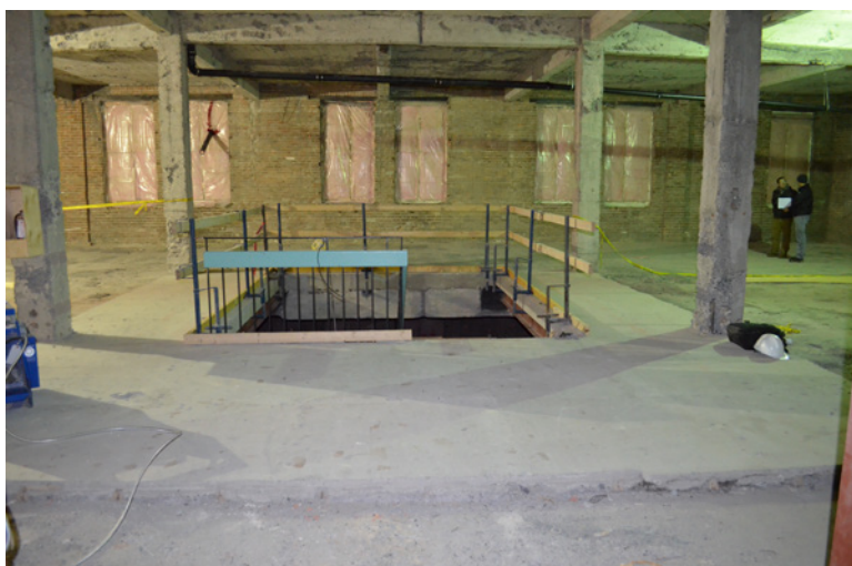
Escalier dans l'aile est : dalle de béton refaite au périmètre de la trémie de l'escalier.
