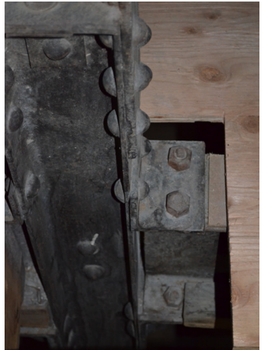
Poteau d'acier de la structure du corps central : raccord riveté au niveau du plancher.
