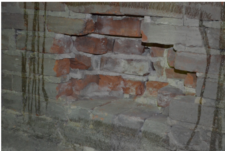
Ouvertures pratiquées dans le mur extérieur de brique pour échantillonnage de matériaux susceptibles de contamination.
