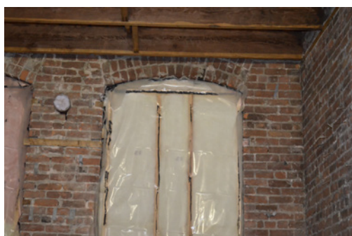
Fenêtre en façade arrière dans l'aile centrale : arc surbaissé en brique.
