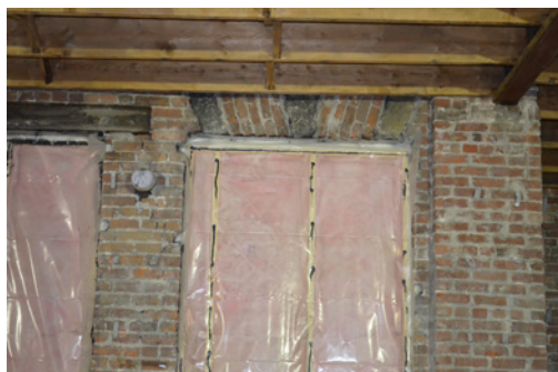
Fenêtre en façade sur rue dans l'aile centrale : arc plat de brique et de pierre.
