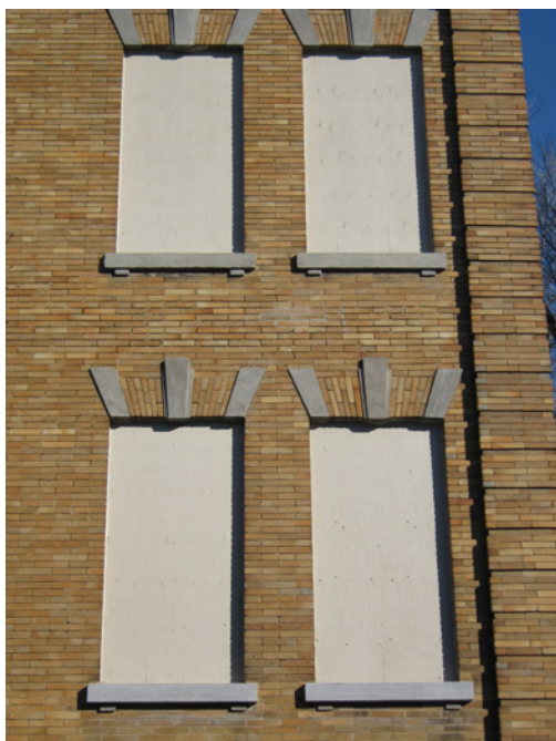
Maçonnerie des façades sur rue : briques et pierres de bonne qualité et en bon état.
